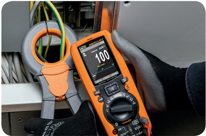
Mesure du courant de fuite.
